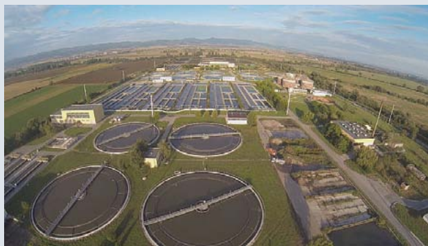
Фиг. 2.14 Софийска пречиствателна станция
